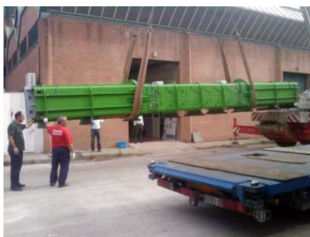
Fase 1 de Proyecto Base: Construcción de máquina lineal.
